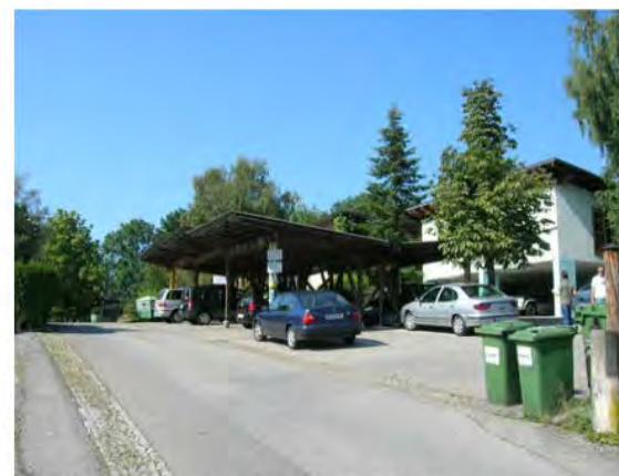
Einfahrt mit Parkplatz, Flugdach und Werkstatt
